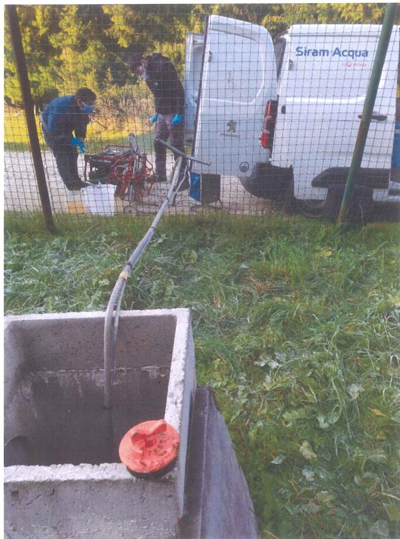
Foto 1: operazioni di prelievo delle acque sotterranee
