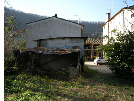
porzione da demolire
