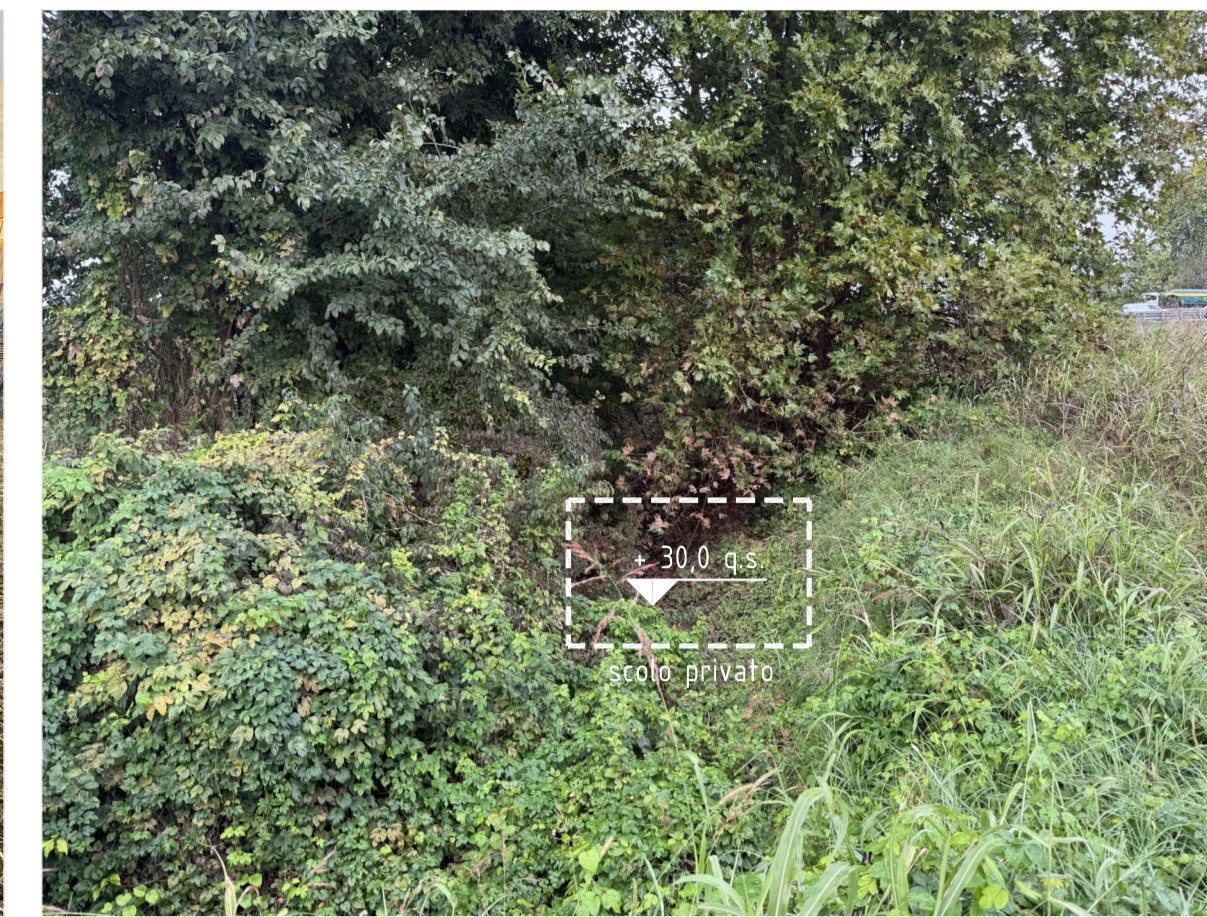
VISTA 4 Vista dello scolo a sud dell'autostrada, all'uscita del tratto interrato, verso il torrente Rielo NOTA: quota altimetrica stimata da C.T.R.
