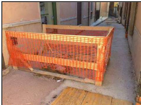
Pozzetti e ogni tipo di portello, buche e scavi aperti anche per un tempo brevissimo, dovranno essere recintati utilizzando transenne come rappresentato nella figura a fianco, o equivalente sistema di segnalazione e delimitazione.
