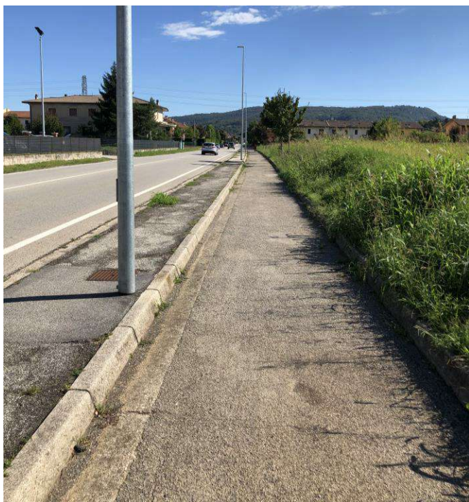
Vista di marciapiede, pista ciclo-pedonale e dei terreni agricoli sulla destra, separati da cordolo alto circa 10 cm
