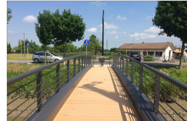
PROPOSTA DI PROGETTO DELLA PAVIMENTAZIONE CON DOGHE FIBROCOMPOSITE
