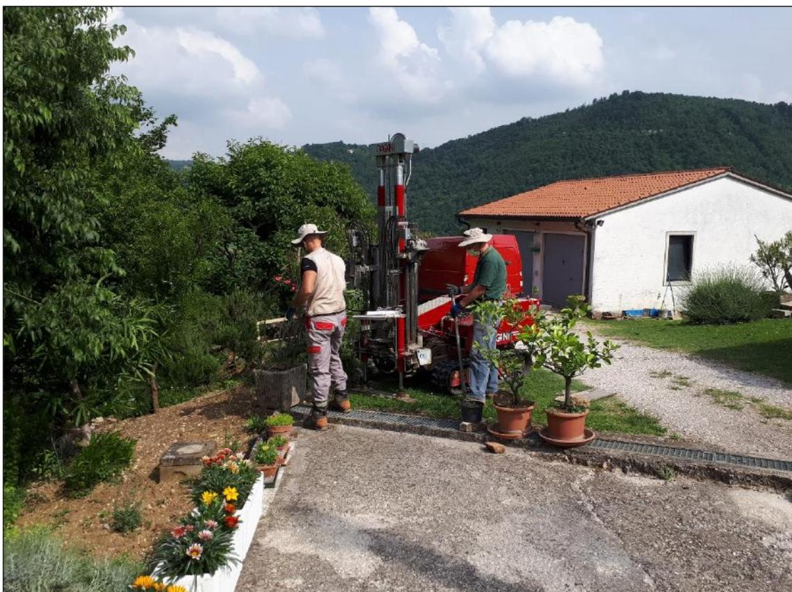
Fig. 18 Penetrometro su prova DPSH3
