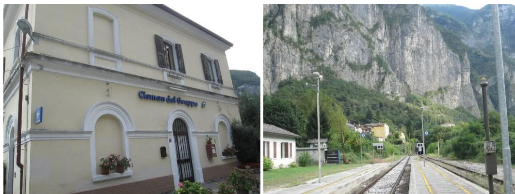
Apparecchi di illuminazione privati Stazione Valbrenta
