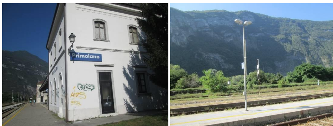
Apparecchi di illuminazione privati Stazione Primolano
