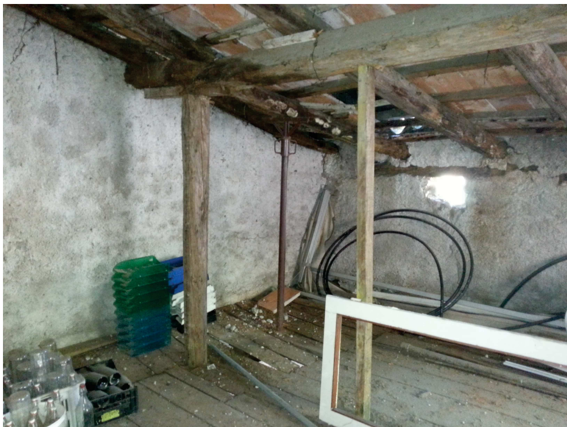
Particolare puntellazione copertura
