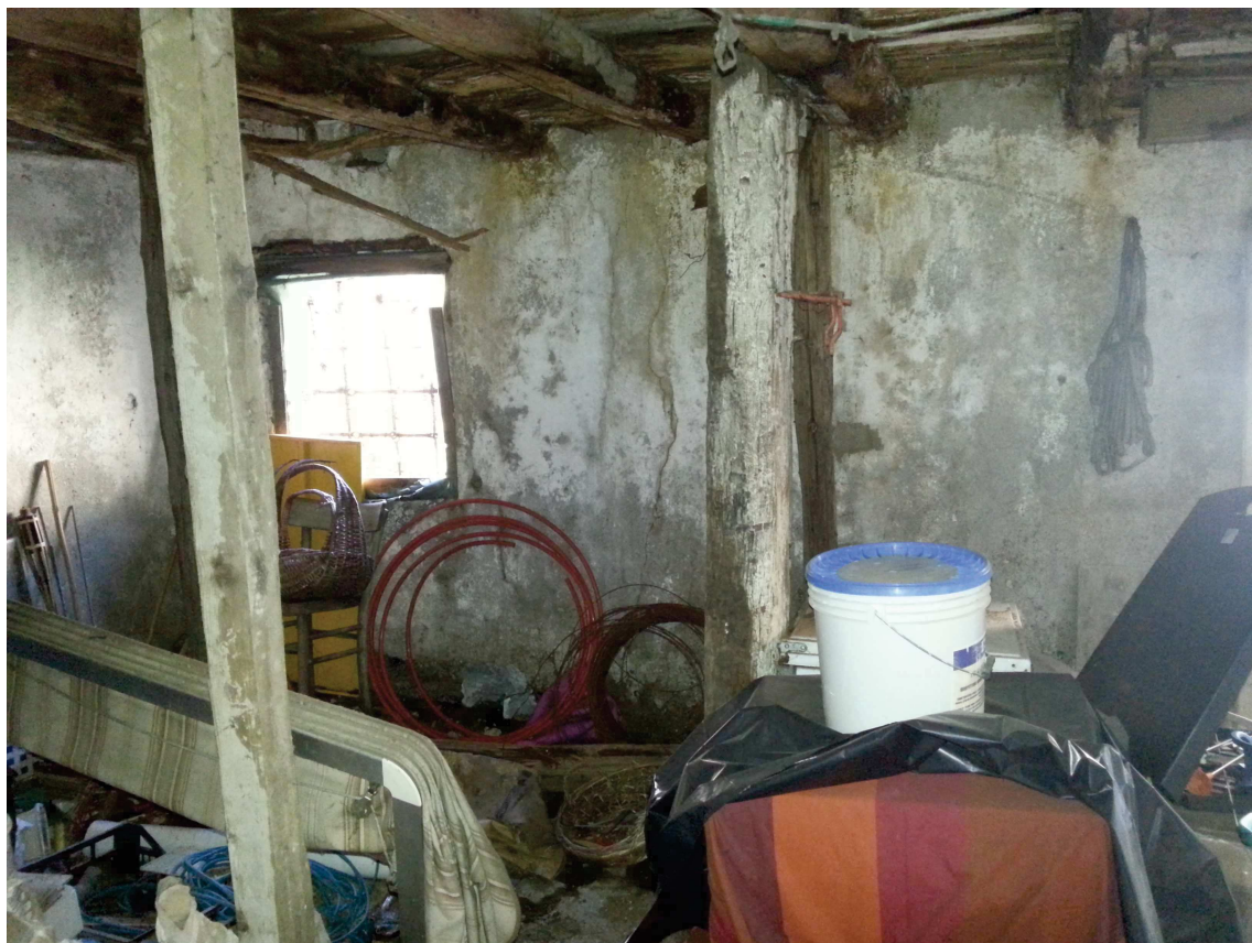
Particolare puntellazione solaio
