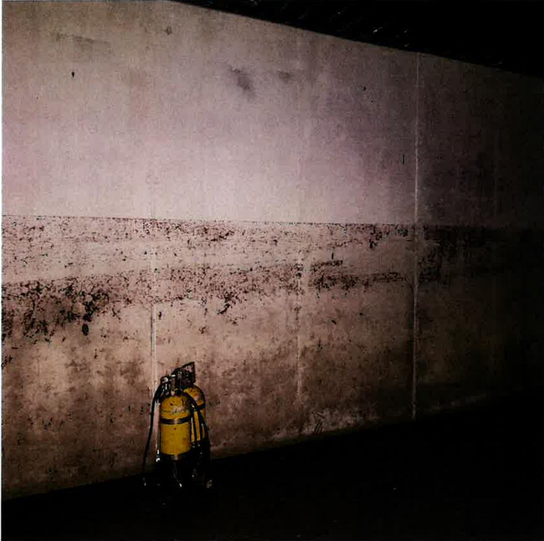
**FOTOGRAFIA.** Locale interrato con il livello raggiunto dall'acqua durante la serata del 08.10.2024.
