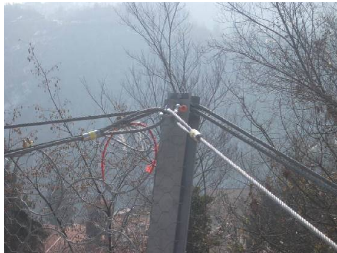
Particolare collegamento funi in testa ai montanti.
