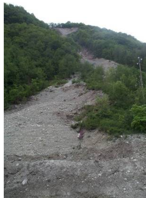
Foto della frana
