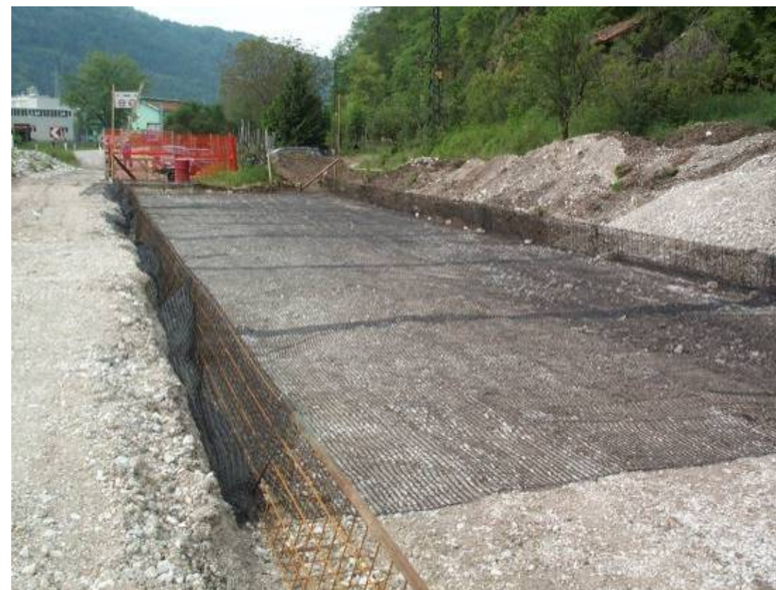
Strato di base della struttura in terra rinforzata
