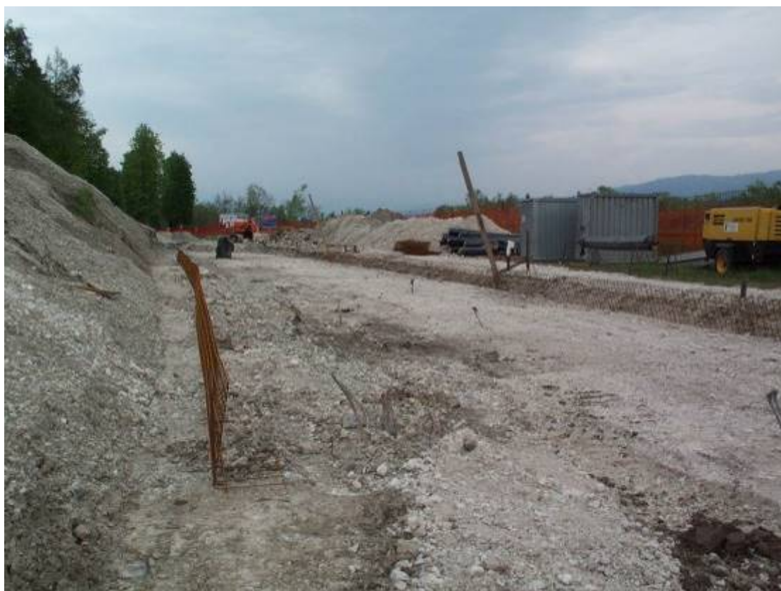
Preparazione del piano di posa per la realizzazione della struttura in terra rinforzata
