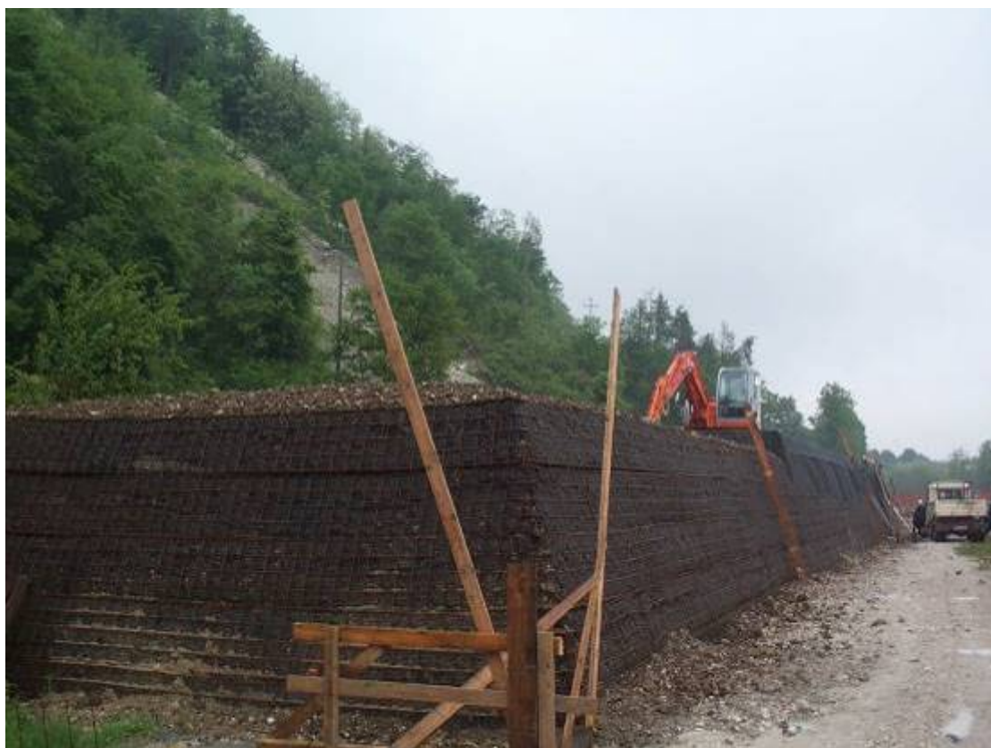
Fase di realizzazione delle strutture in terra rinforzata
