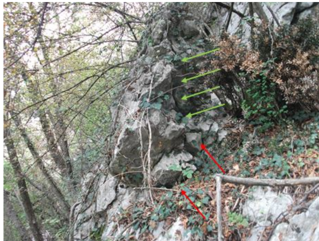
Particolare di massa in distacco
