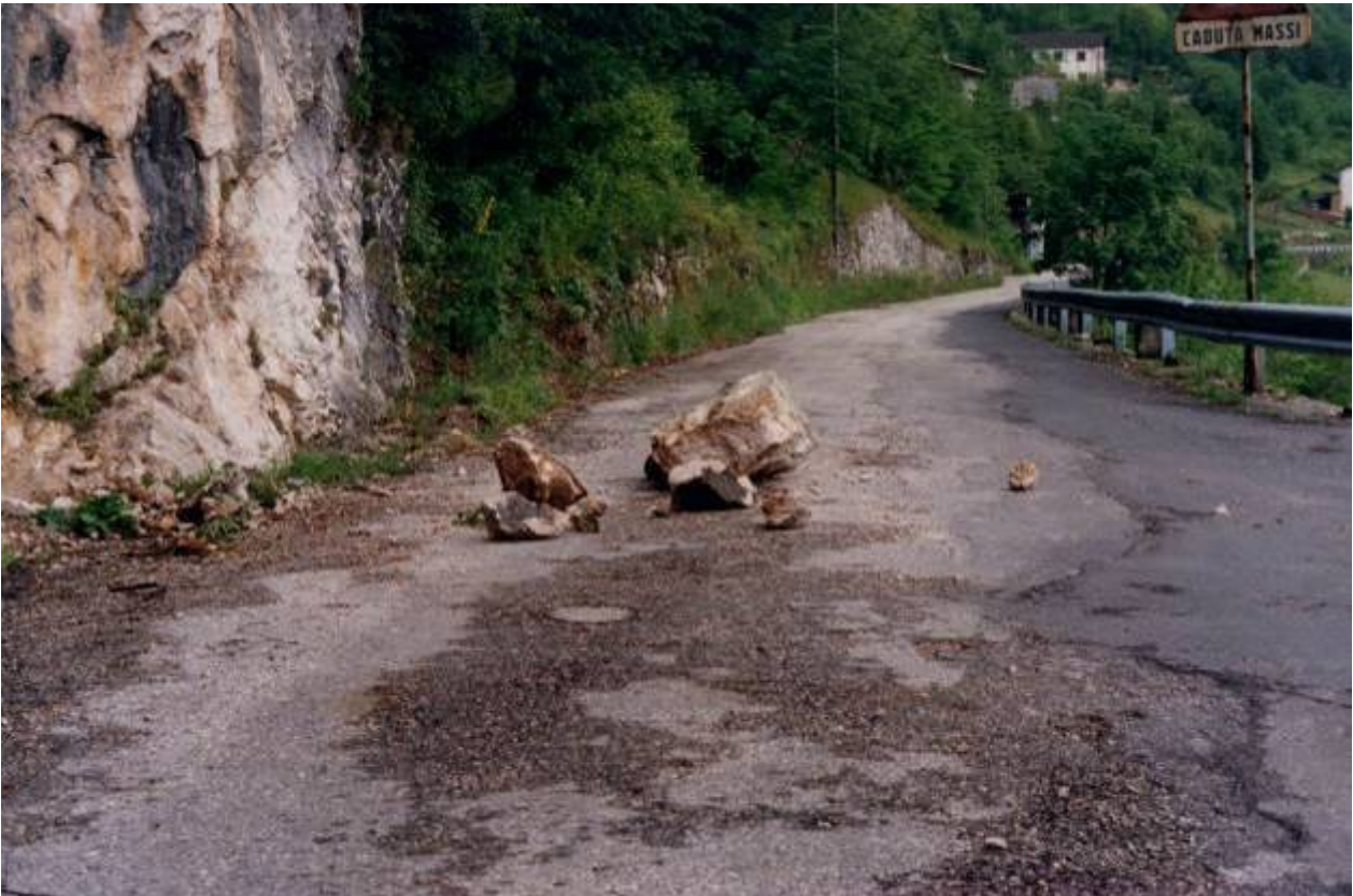
Massi caduti sulla sede stradale
