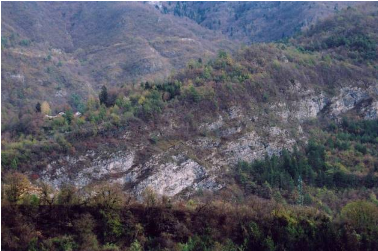
Vista generale della parete da mettere in sicurezza
