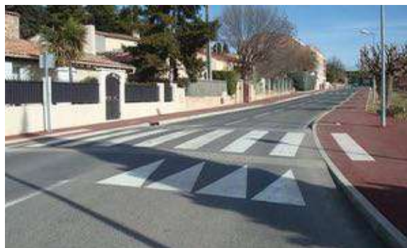
Attraversamento con "isola salvagente" e attraversamento rialzato
