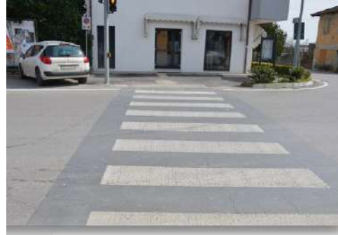
Vernice con microsfere rifrangenti e semaforizzazione
