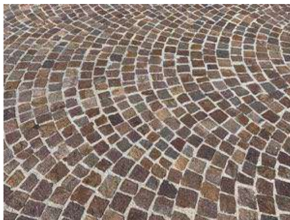
Davanti al Conad a Vigonovo - le fughe del pavimento sono correttamente sigillate
