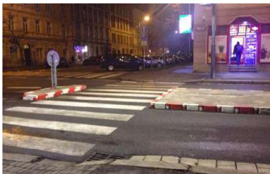
Attraversamento con "isola salvagente" e attraversamento rialzato
