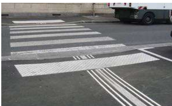
Es. attraversamento marciapiede con contrasto cromatico e strisce tattili (in resina)
